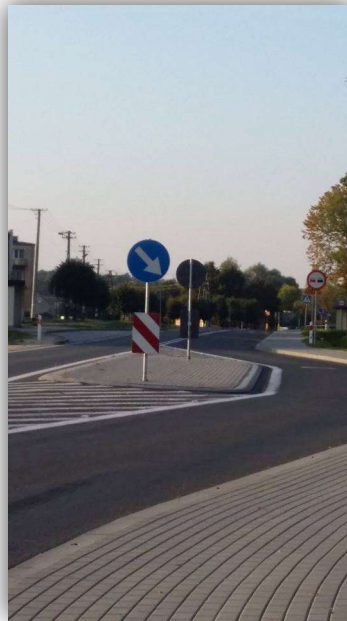
Rysunek 22 Zastosowanie wyseppek w celu zredukowania prędkości pojazdów (źródło: zdjęcie własne)
