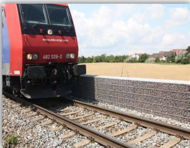
Rysunek 28 Przykładowe zastosowanie niskich ekranów (źródło: https://www.heringinternational.com/en/nc/news/article/for-the-sake-of-the-environment-testing-low-noise-barriers-along-railway-tracks/ )
