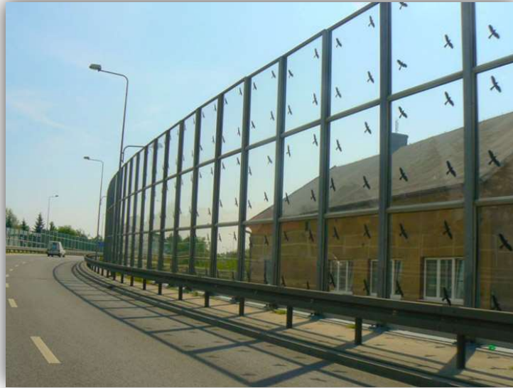
Rysunek 26. Zastosowanie przezroczystego ekranu z akrylu (źródło: http://ro.com.pl/ogranicza-liczbe-ekranow-dzwiekochlonnych-na-drogach/01151290 )
