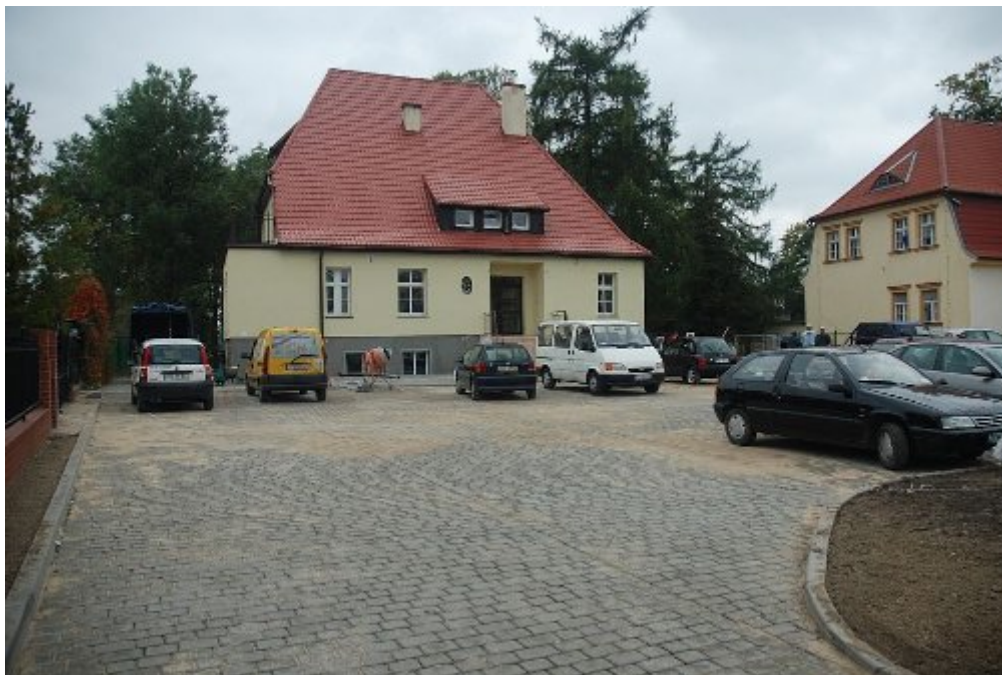
Budynek i parking Wydziału Geodezji po remoncie
