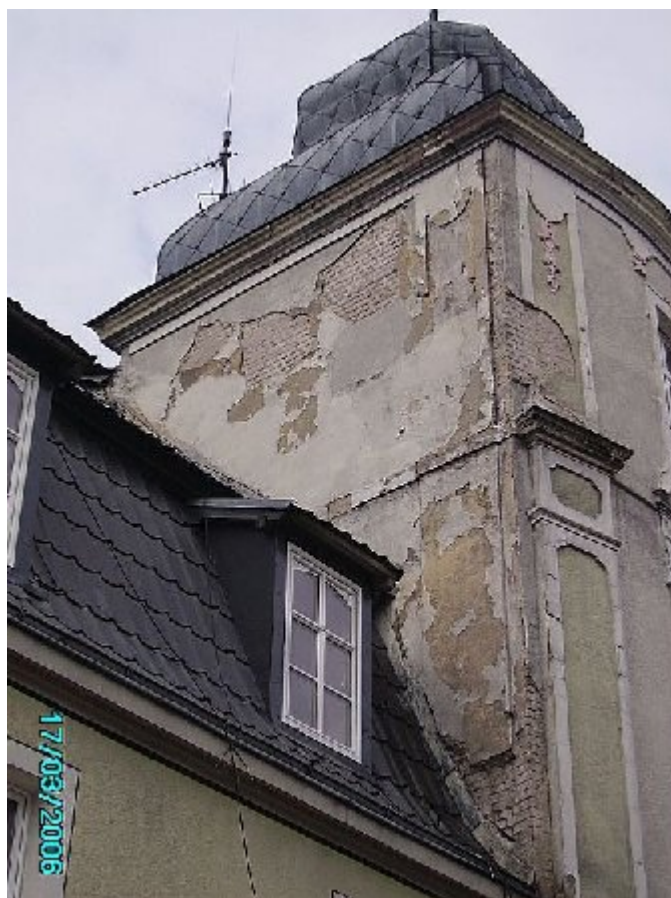
Budynek główny przed remontem elewacji.
