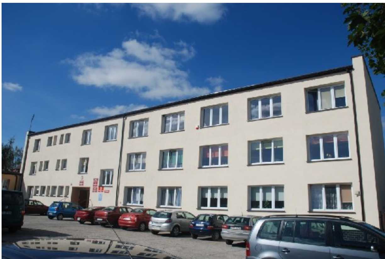
Zmodernizowany budynek internatu – widok od strony dziedzińca
