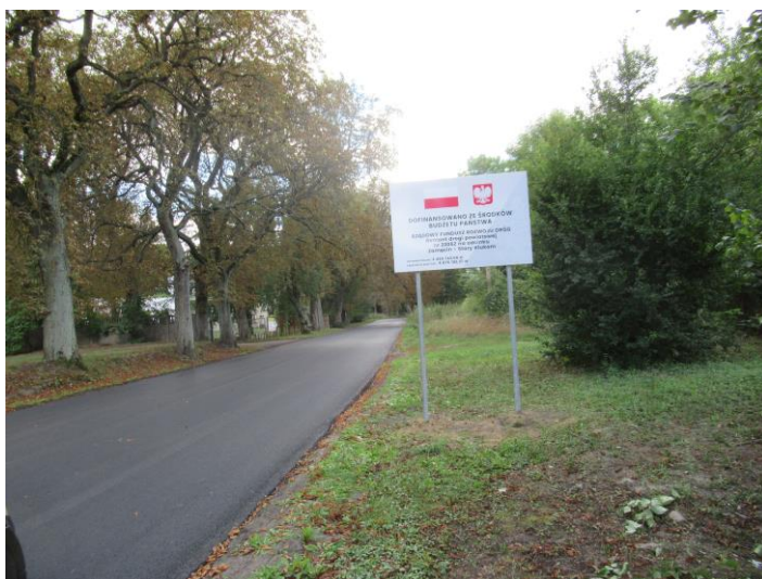
Zdjęcie 29. Droga powiatowa nr 2206Z na odcinku Zamęcin - Stary Klukom
