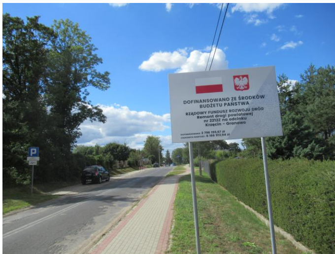
Zdjęcie 30. Droga powiatowa nr 2212Z na odcinku Krzęcin - Granowo
