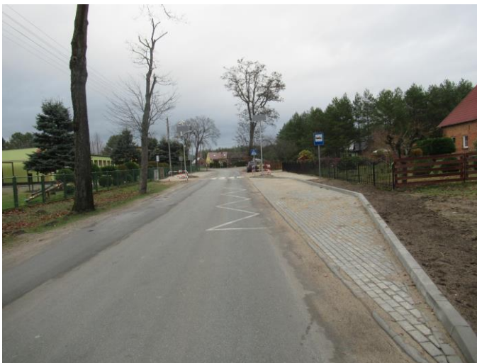
Zdjęcie 28. Zatoka autobusowa wraz z chodnikiem w ciągu drogi powiatowej nr 2240Z w m. Łasko
